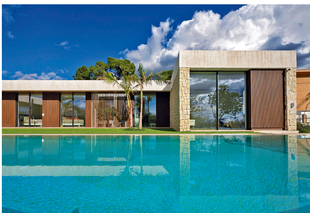
IMAGEN DE PROYECTO ACABADO DEL ARQUITECTO · IMAGE OF A FINISHED PROJECT BY THE ARCHITECT Antonio Altarriba
