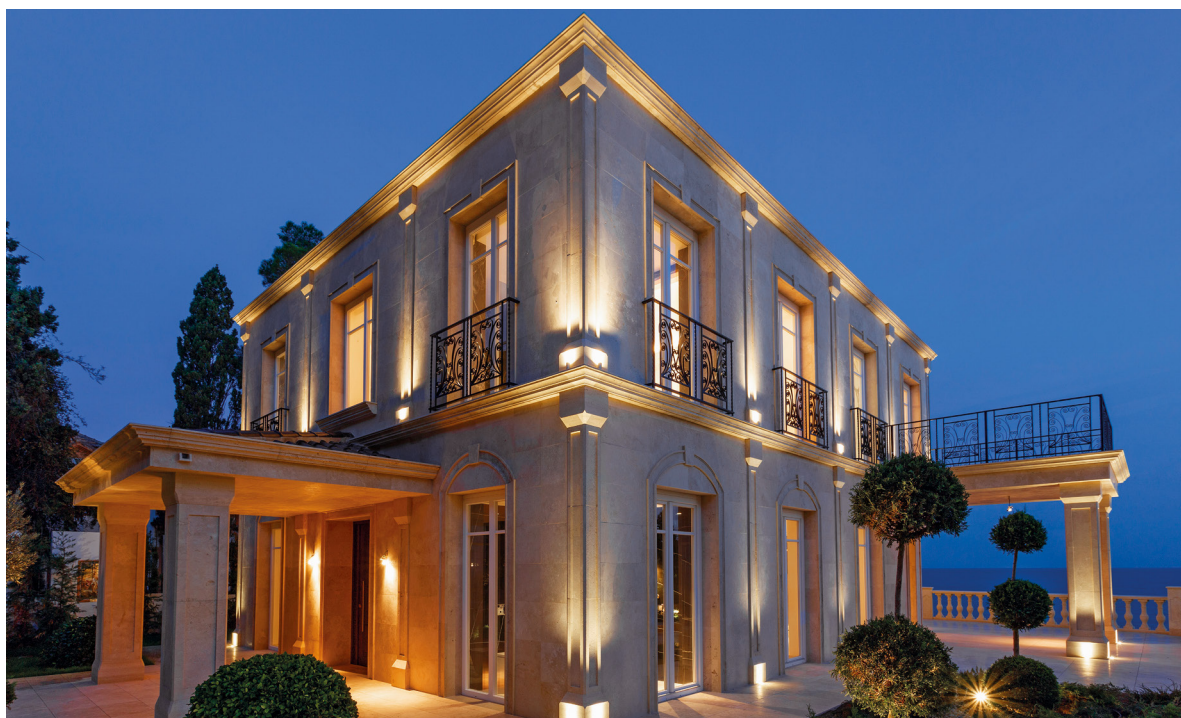
Vista Norte de la vivienda. Piscina desbordante revestida de azulejo cerámico de gran formato North view of the house. Overflow pool with large format ceramic tiles
